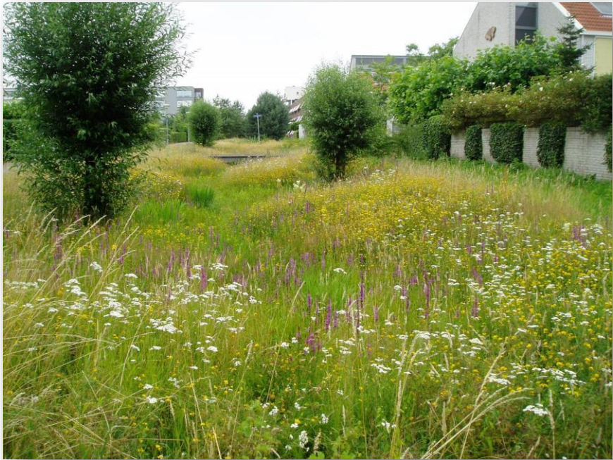
Wadi voor de opvang van regenwater
