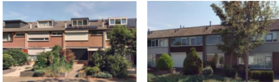
Afbeeldingen 3.6 - Twee dominante typen grondgebonden woningen in Wisselaar-oost (bron: Geoweb)
